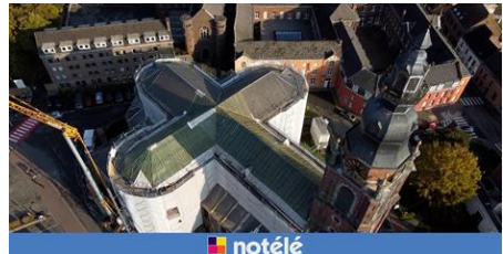
La collégiale durant les travaux – Photo NOTELE
