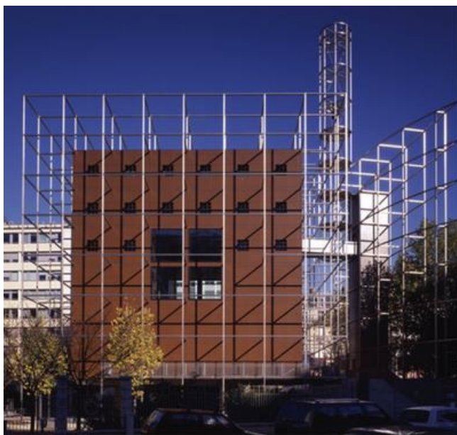
FIG. 1 : L'ÉGLISE NOTRE-DAME DE L'ARCHE D'ALLIANCE, VUE EXTÉRIEURE AVANT LA POSE DES VITRAUX ET DE LA CROIX © ARCHITECTURE STUDIO
