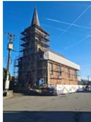
**A Chapelle-à-Oie** - L'échafaudage a été installé autour du bâtiment afin de commencer le remplacement de la toiture ; ensuite viendra le travail de réfection du plafonnage à l'intérieur du bâtiment.
