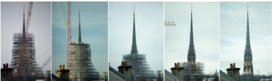
Cinq images prises (de gauche à droite) le 14 février 2024, le 15 février 2024, le 2 mars 2024, le 9 mars 2024 et le 18 mars 2024 montre le démontage de l'échafaudage entourant la nouvelle flèche de la cathédrale Notre-Dame de Paris. (ERIC BARADAT / AFP)
